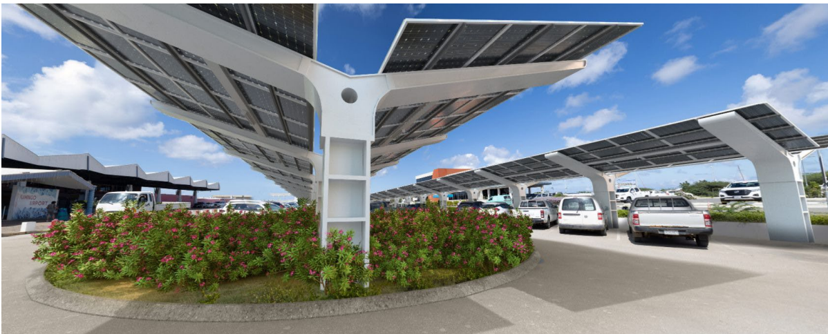
Voorbereiding van het zonnepark op P1 draagt bij aan de verduurzaming van de luchthaven.
